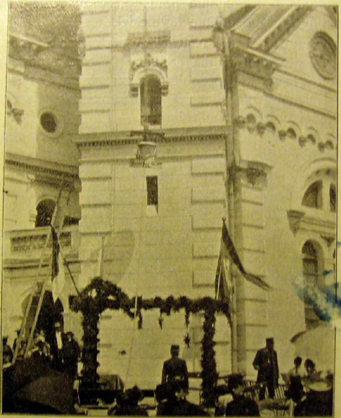
Wyciąganie ostatniego dzwonu.
